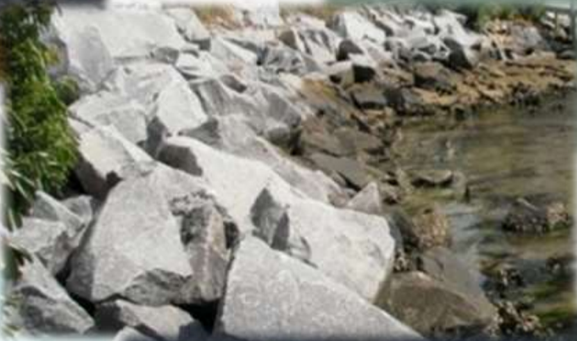
Riprap Revetment
