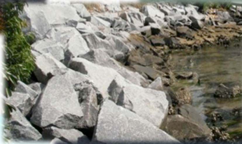
Riprap Revetment
