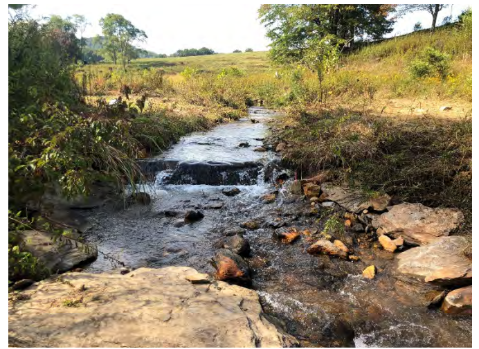
Vile Creek R2: STA 123+00 – Rock Sill Repair 9-28-2021
