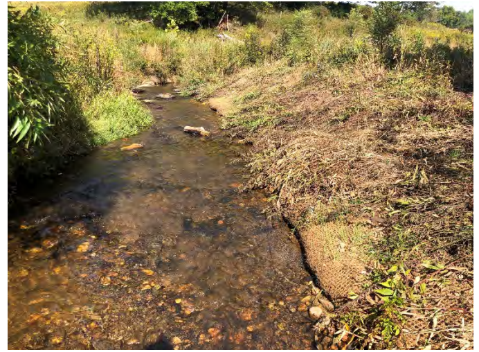
Vile Creek R2: STA 121+00 - 121+25 - Right Bank Repair 9-28-2021
