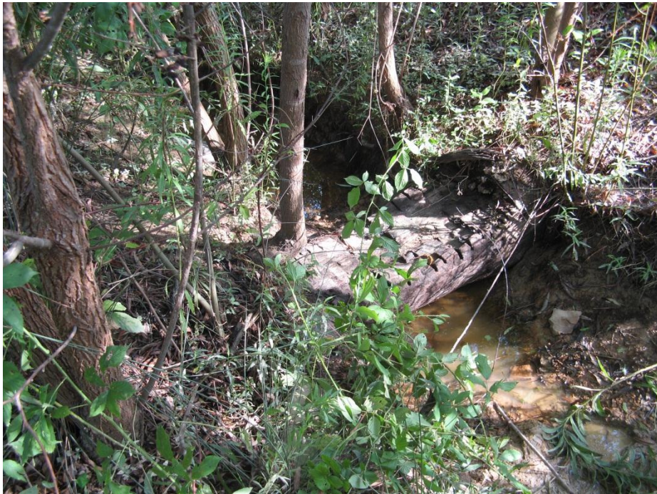
Photo Point 4 (Washed out sill log)
