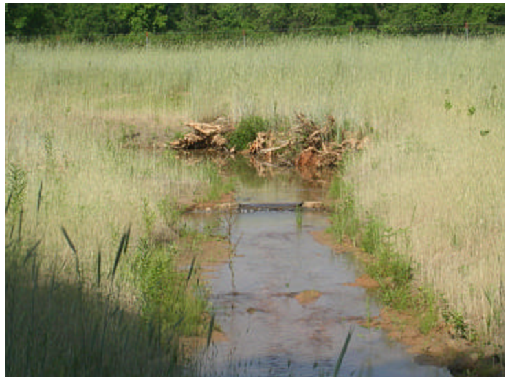
UT3 log weir_2
