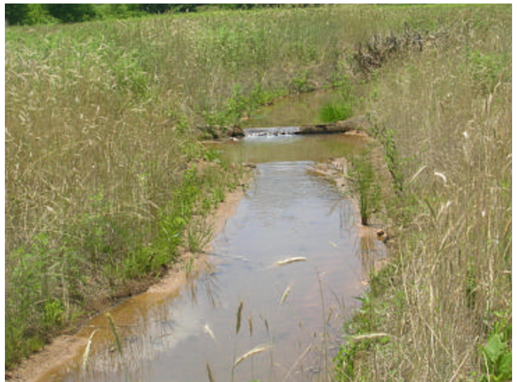
UT1 log weir
