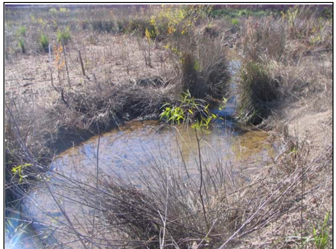
UT3 Log Weir 5
