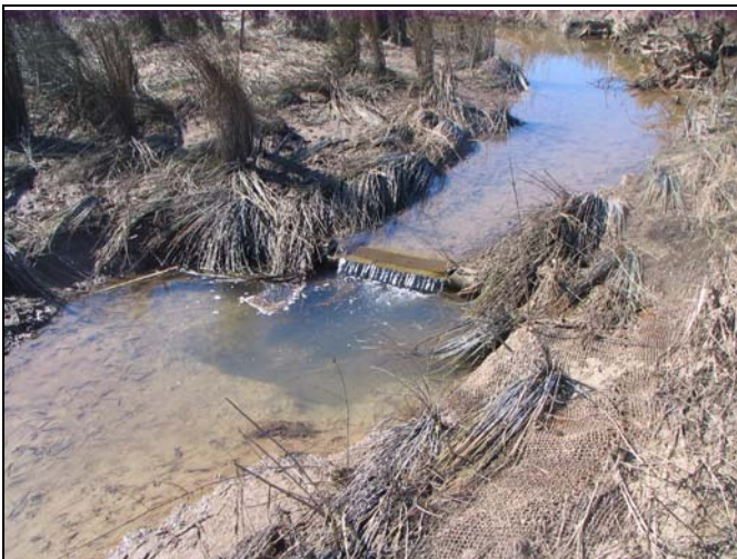
UT3 Log Weir 4
