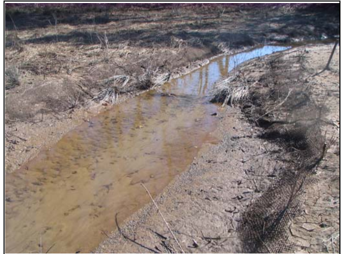
UT3 Log Weir 3
