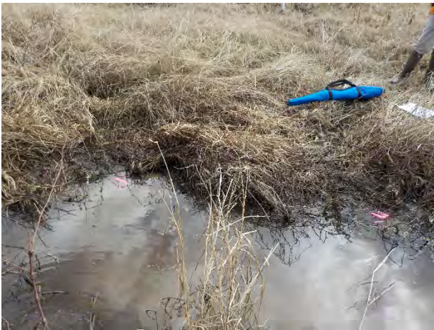
Bank Pin Array 3 UT1 STA 6+25 (2/9/2016)
