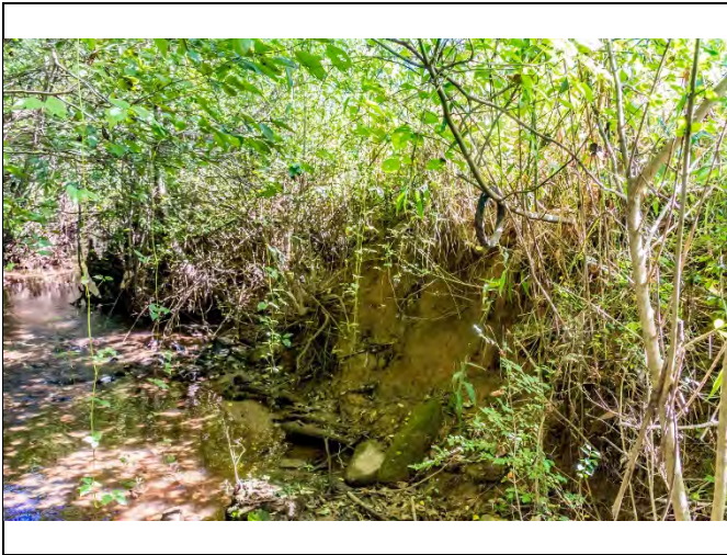
Upper Reach R1, right bank (Aug 2017)
