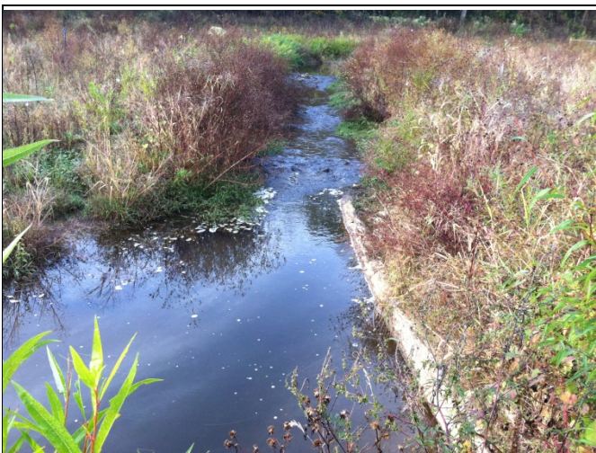
PP 5 STA 59+10, Log J-Hook
