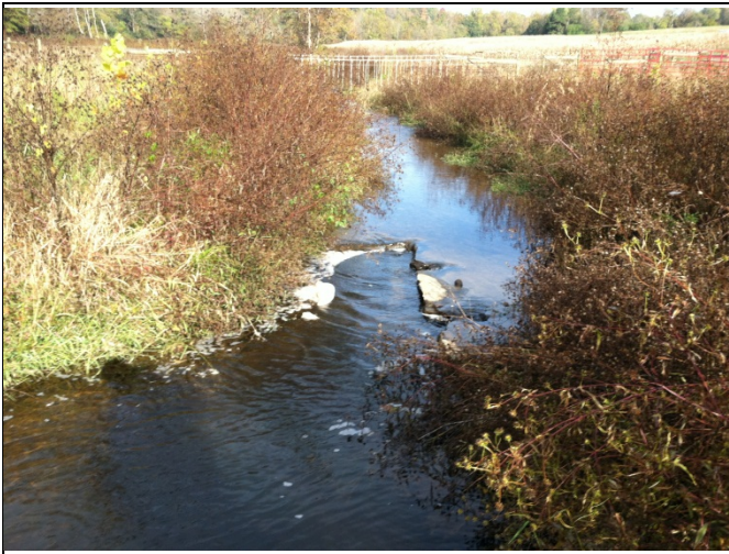
PP 39 STA 33+90, Rock J-Hook
