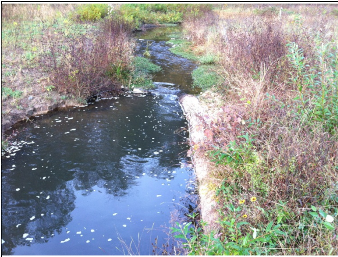
PP 9 STA 56+70, Log J-Hook
