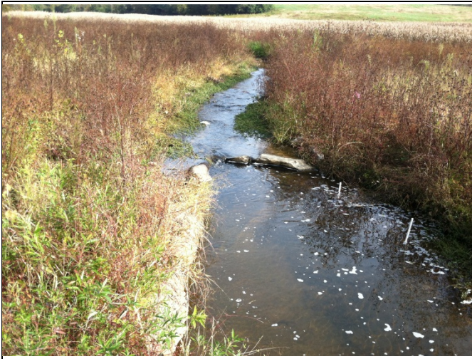
PP 49 STA 27+10, Log J-Hook
