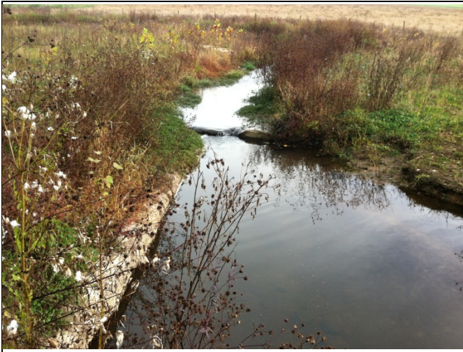
PP 19 STA 49+15, Log J-Hook
