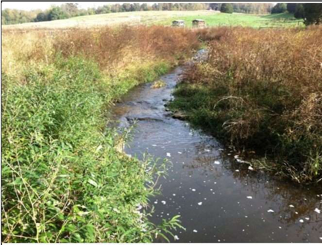
PP 37 STA 35+05, Log J-Hook
