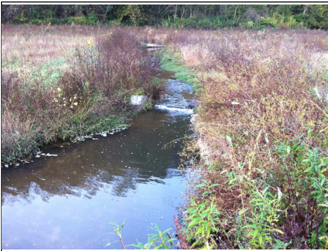
PP 17 STA 50+75, Log J-Hook
