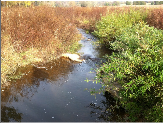
PP 25 STA 45+25, Rock J-Hook
