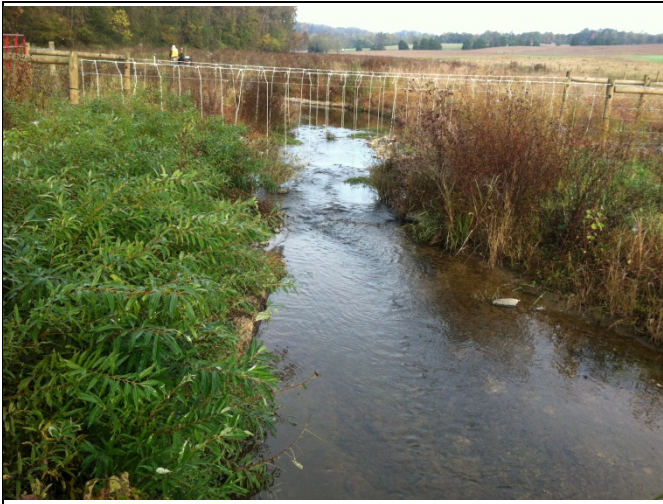
PP 7 STA 57+65, Log J-Hook
