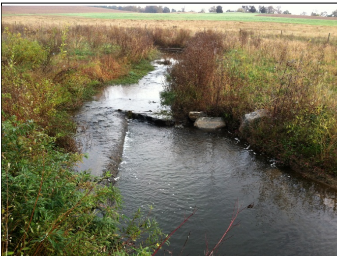
PP 11 STA 55+40, Log J-Hook
