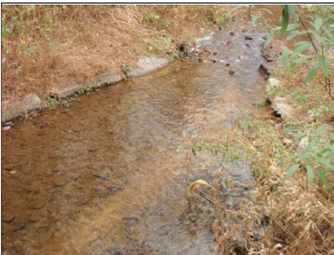
PP 59 STA 17+75, Rock Cross Vane
