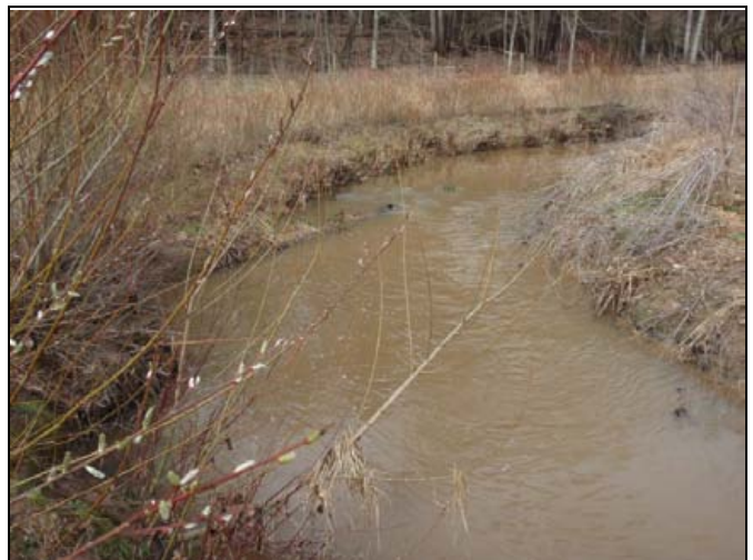
PP 48 STA 27+75, Log Vein/Pool
