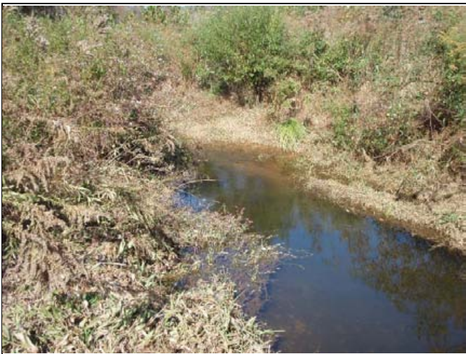
PP 35 STA 36+75, Rock J-Hook
