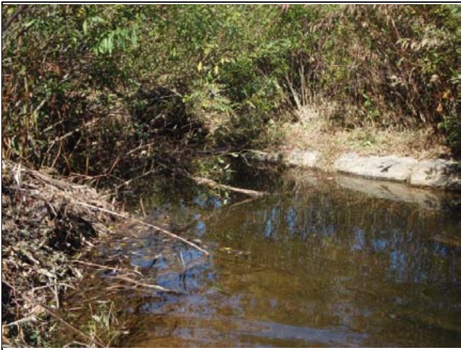
PP 51 STA 25+65, Rock J-Hook
