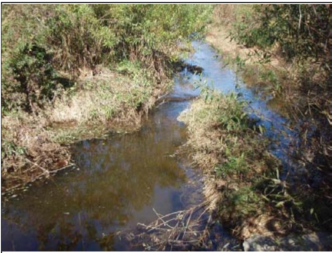
PP 39 STA 33+90, Rock J-Hook
