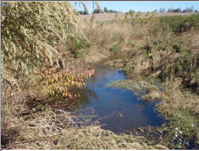
PP 19 STA 49+15, Log J-Hook
