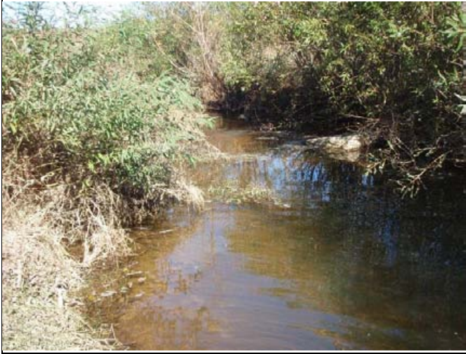
PP 25 STA 45+25, Rock J-Hook
