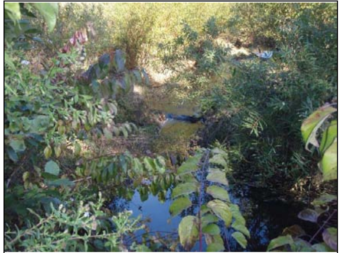
PP 44 STA 30+55, Log J-Hook
