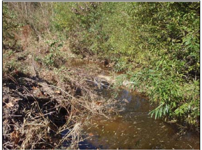
PP 46 STA 28+80, Log J-Hook
