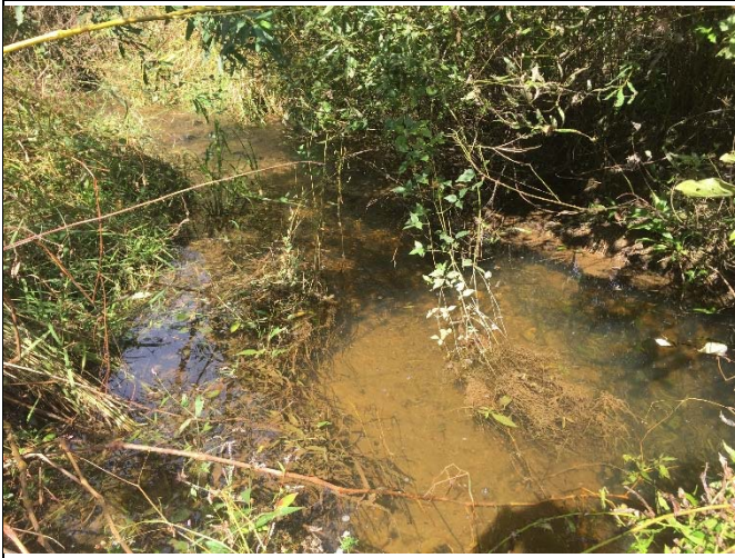
PP 55 STA 22+90, Log J-Hook
