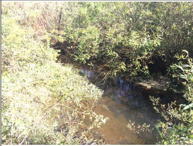
PP 25 STA 45+25, Rock J-Hook
