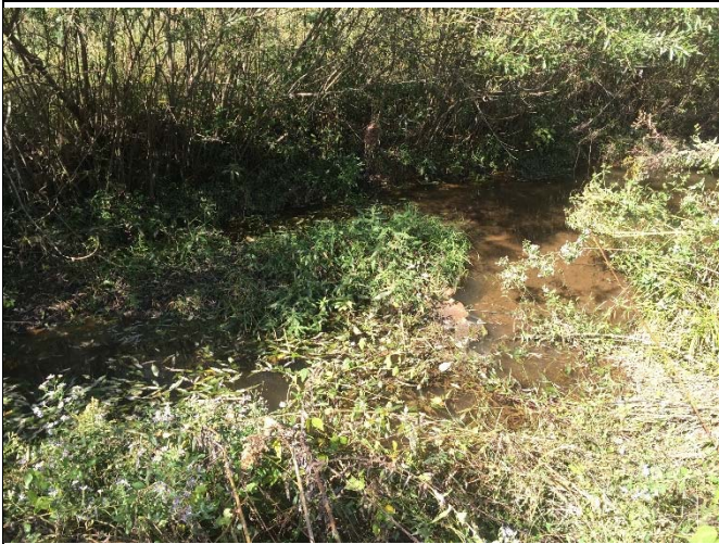
PP 33 STA 38+50, Rock J-Hook
