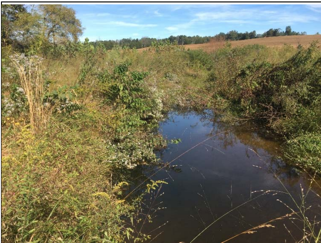
PP 23 STA 46+15, Log J-Hook
