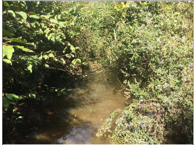
PP 44 STA 30+55, Log J-Hook
