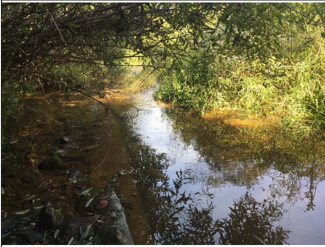
PP 37 STA 35+05, Log J-Hook
