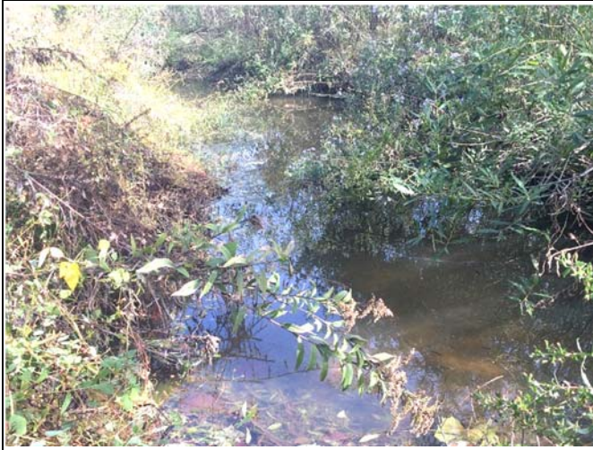
PP 49 STA 27+10, Log J-Hook
