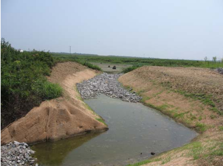
PP2 Pond 1 tie in UT1A.jpg
