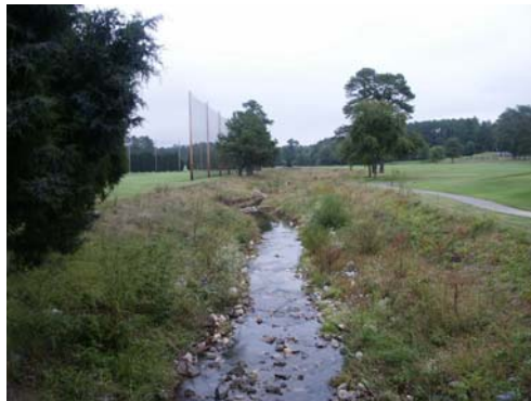
AL-P01 STA 46+46 (BRIDGE)
