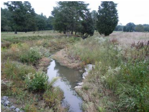
HD-P02 STA 29+77 (BRIDGE)
