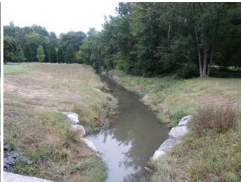
AL-P07 STA 62+45 (BRIDGE)
