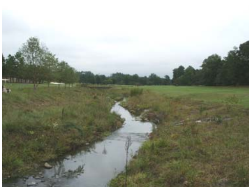
HB-P02 STA 10+43 (BRIDGE)
