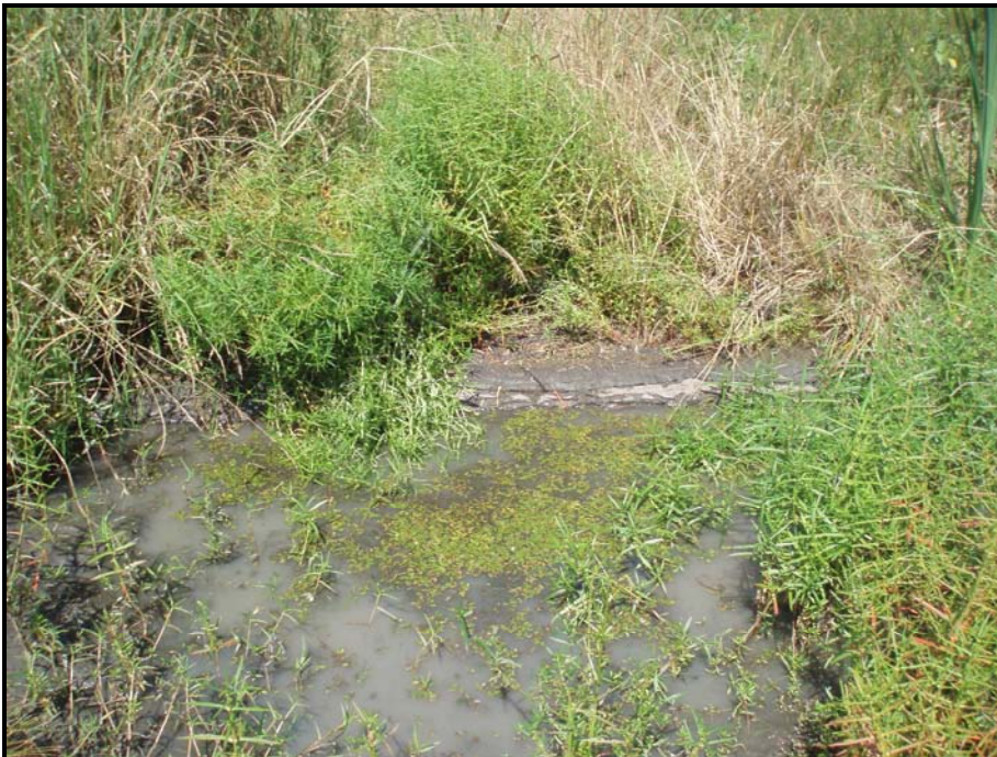
Log weir at STA 74+00
