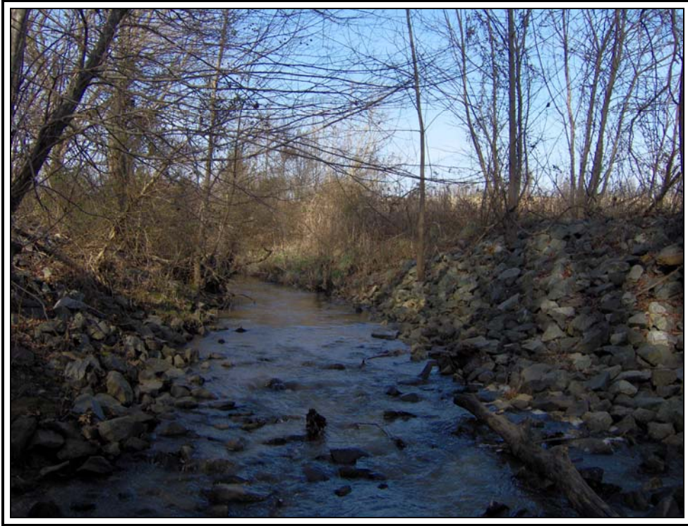
Buckhorn Creek: STA 121+25
