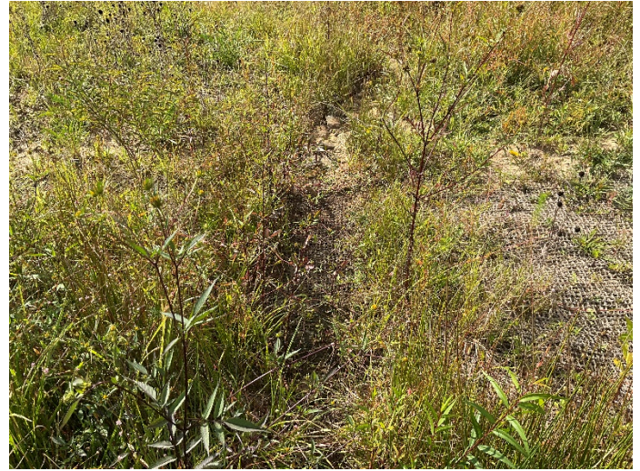
UT1 STA 224+05 – rock stabilization (9/22/2023)
