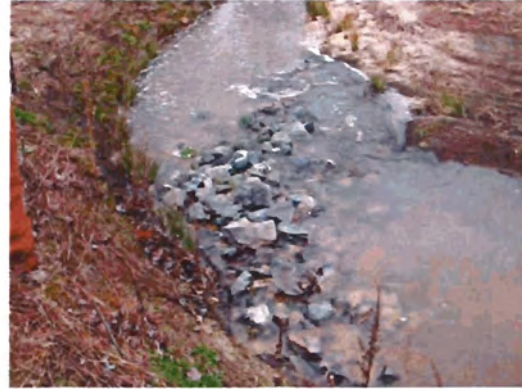
SPA 23. Riprap transverse bar formation. Sta. 36+45.
