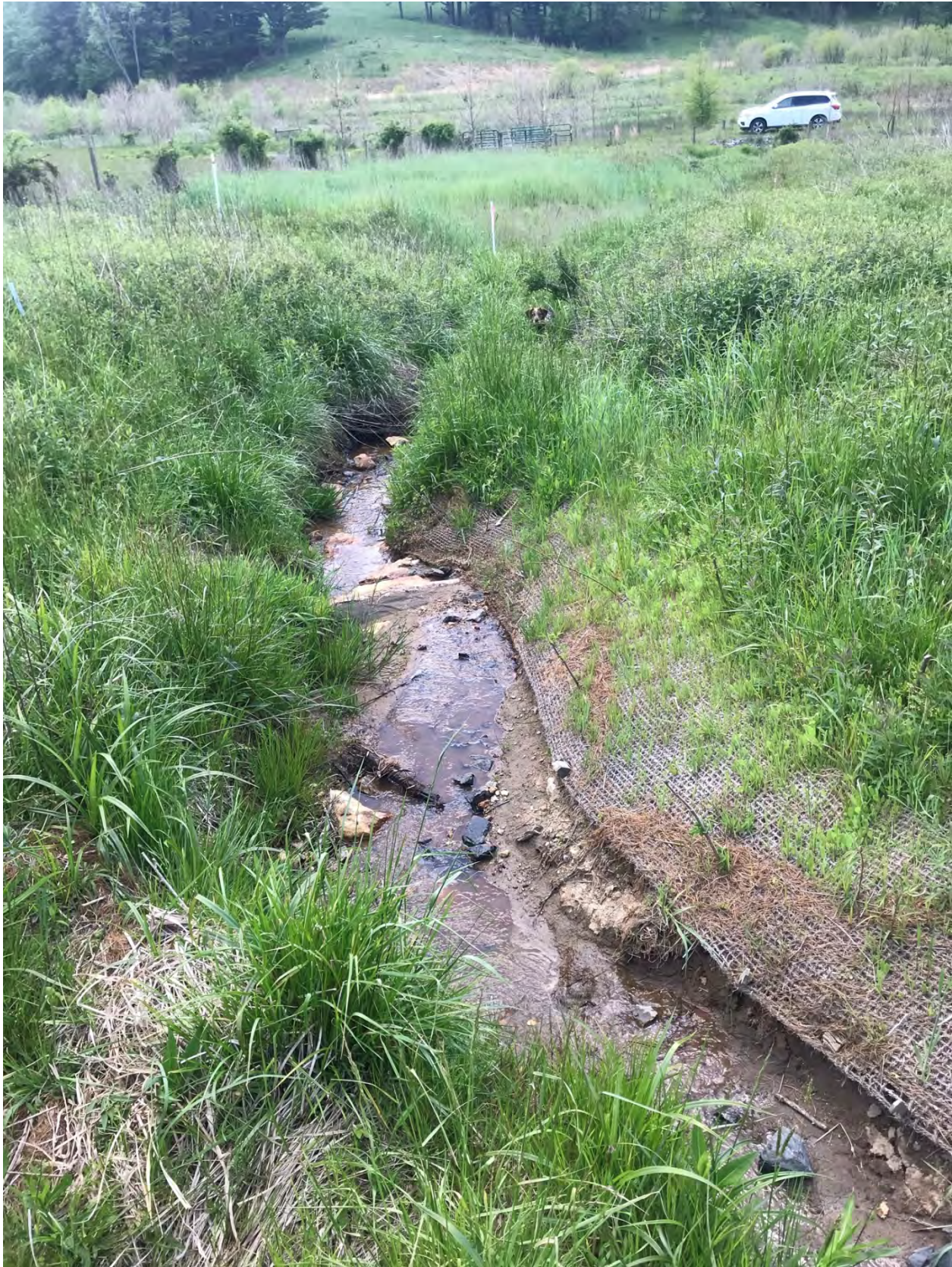
UT 1 Repair Area
