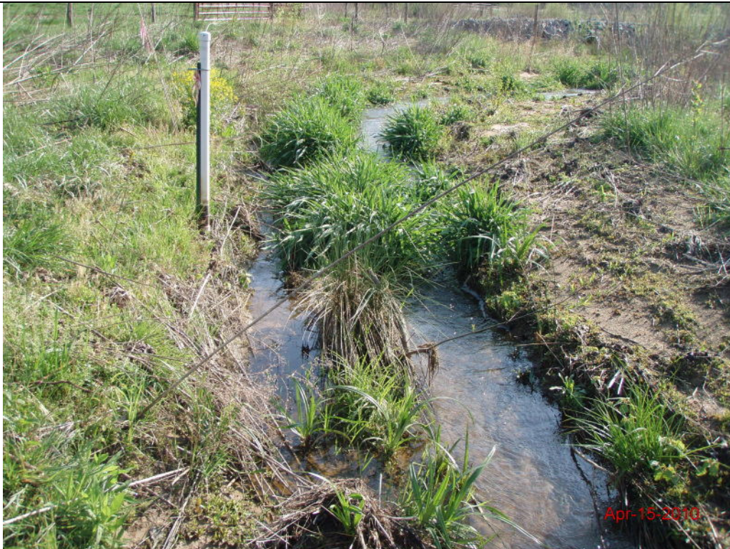
SPA17 UT6 Sta. 7003+00 – Riffle Aggradation
