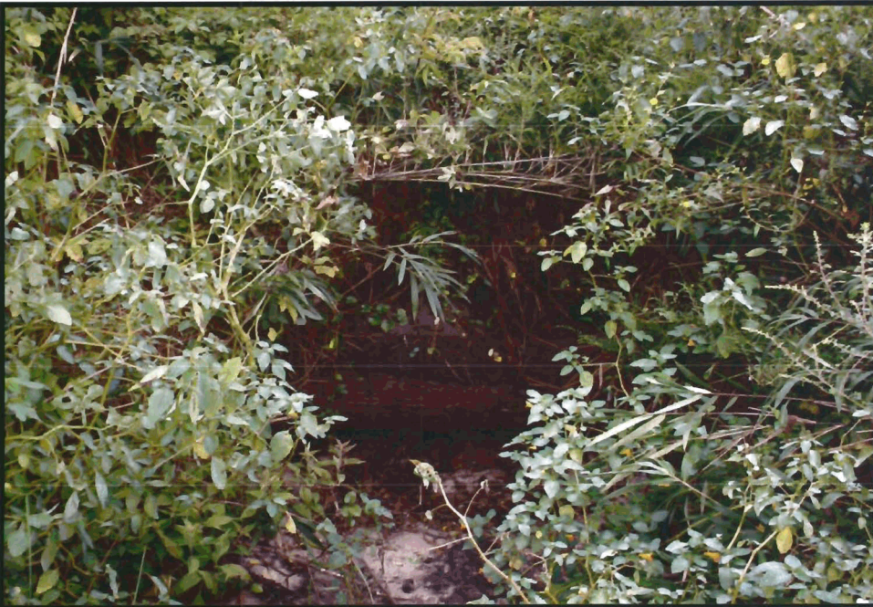
Log weir @ STA 0+60
