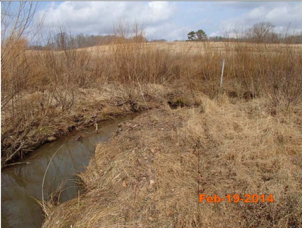
Reach 1 Sta. 320+75 – Wrack Lines
