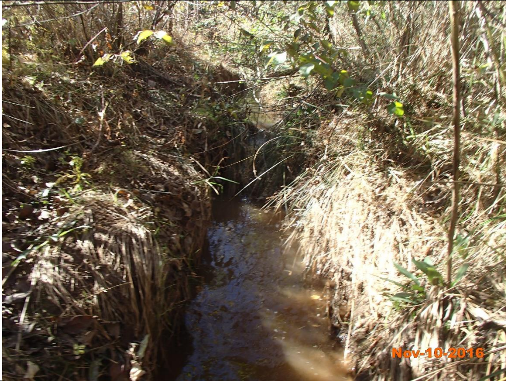
Reach 1 Sta. 313+00 – Riffle Degradation
