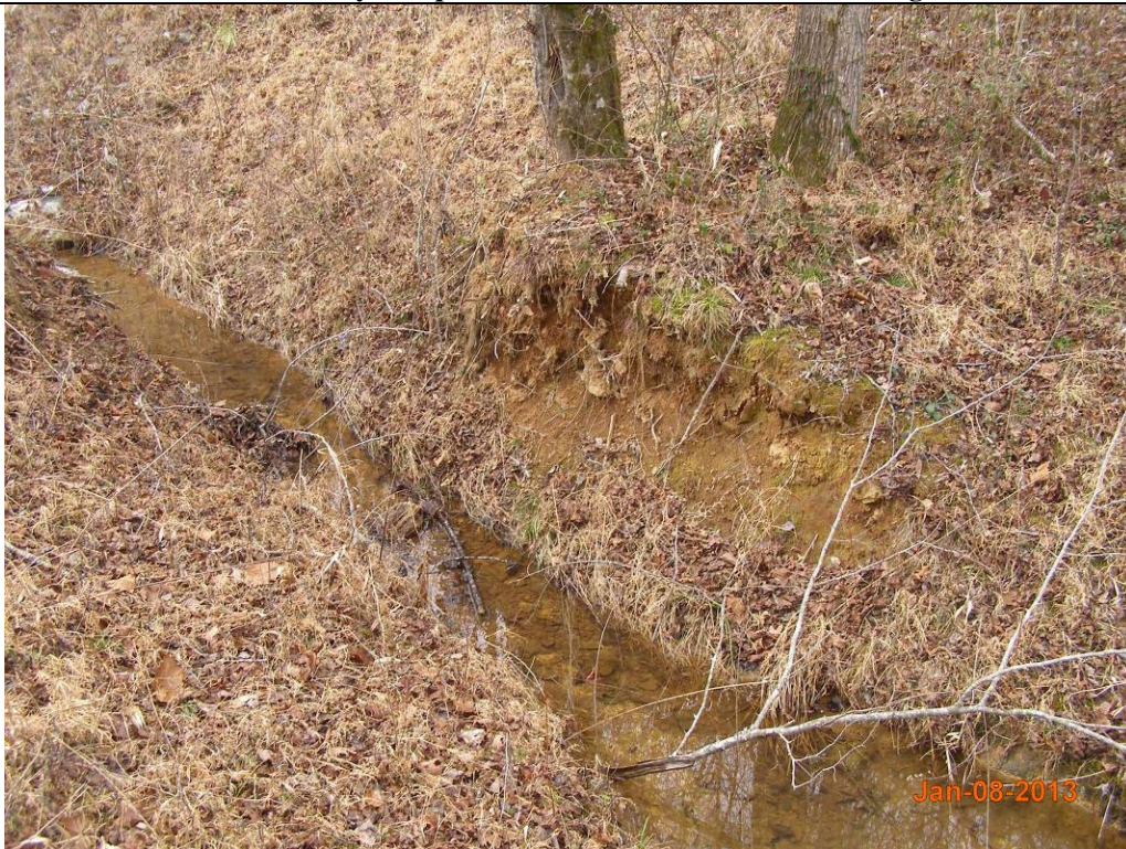
SPA7 UT5 Sta. 515+10 – Bank Scour
