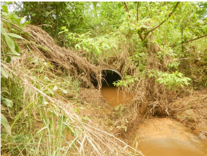
Culvert facing DS (5-8-2013)
