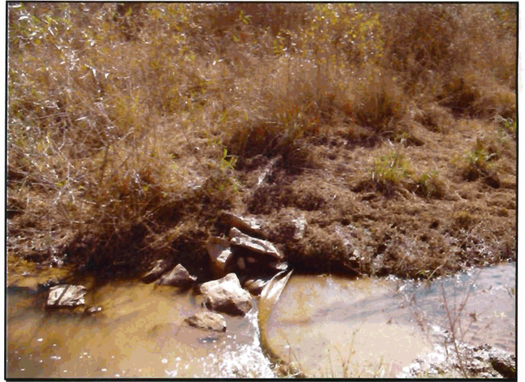
23. Root wads at sta. 51+00
