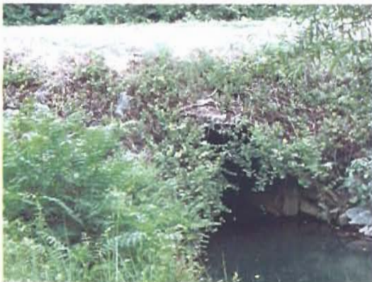
E. Culvert on Buena Vista Creek
