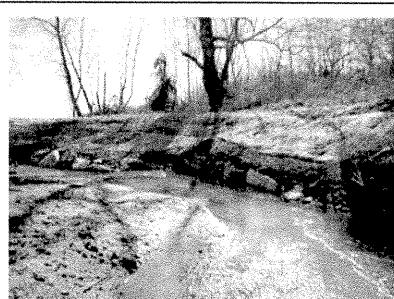
SPP43 - SR1 STA 4+90
