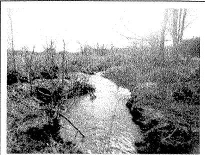
SPP58 - SR2 STA 20+60
