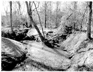
SPP36 - SR1 STA 0+00
