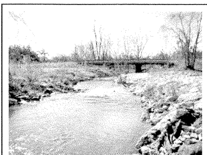
SPP83 - SR2 STA 52+00 – Project End
