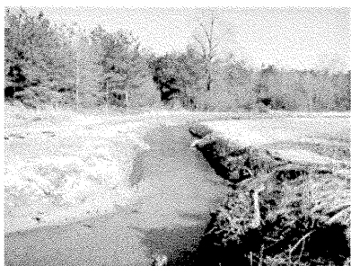
SPP50 - SR1 STA 12+10
