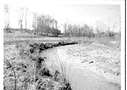
SPP76 - SR2 STA 42+00
