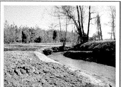
SPP44 - SR1 STA 5+25
