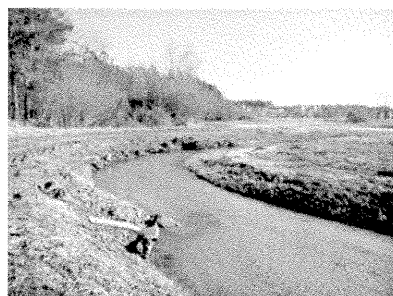
SPP51 - SR1 STA 13+35
