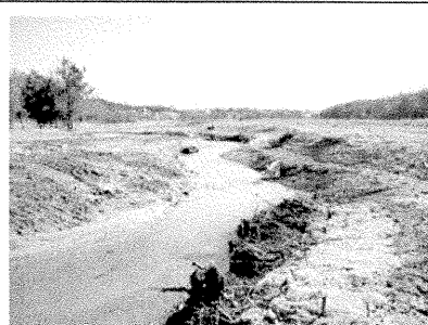
SPP46 - SR1 STA 7+25
