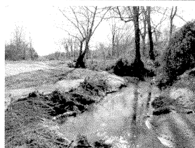
SPP40 - SR1 STA 2+55
