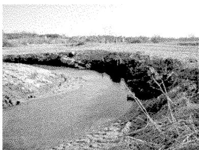
SPP53 - SR1 STA 15+00
