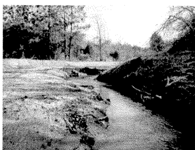
SPP39 - SR1 STA 2+00
