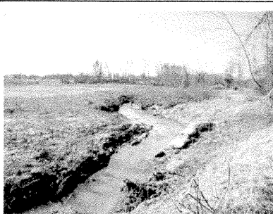
SPP71 - SR2 STA 35+10
