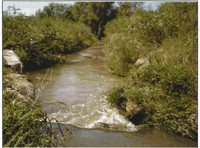
SPP63 - SR2 STA 25+05
