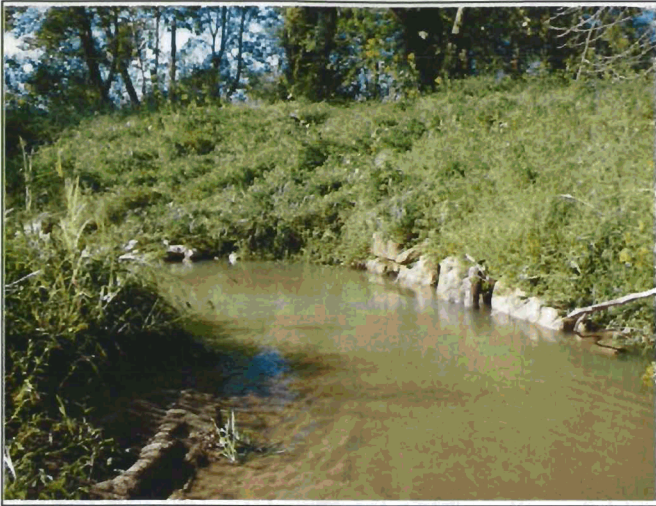
SPP43 - SR1 STA 4+90
