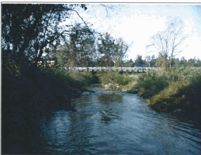
SPP83 - SR3 STA 52+00 - Project End
