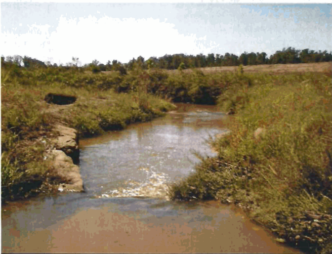
SPP52 - SR1 STA 14+10
