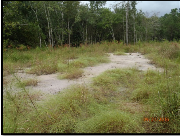
3.10 Bare area STA 25+00
